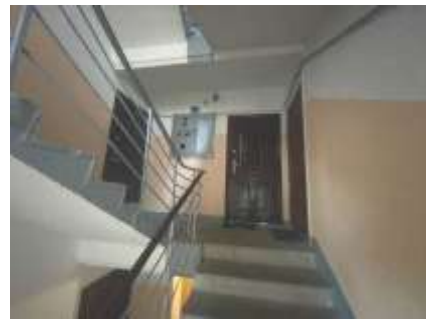
2.stāva kāpņu telpa
